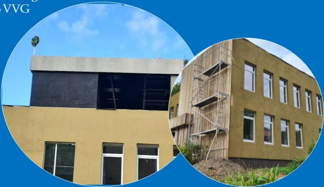
Suremontuotas 302,58 kv.m. ploto neformalaus ugdymo namų „Įgūdžių laboratorija“ pastatas, padidinant jo energetinį efektyvumą: apšiltintos sienos ir stogas, įrengta terasa ant pastato stogo, įrengtas grindinis šildymas (103 kv.m.) ir pastato šildymo sistema. Didinant pastato funkcionalumą, išgriautos ir perstatytos vidaus pertvaros.
